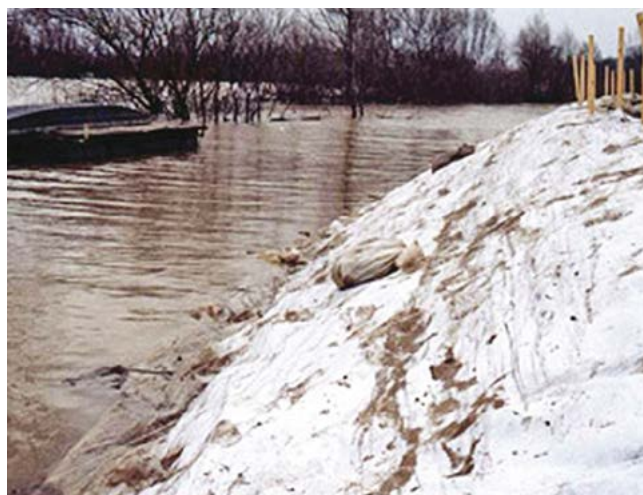
100. ábra Védekezés hullámverés ellen
