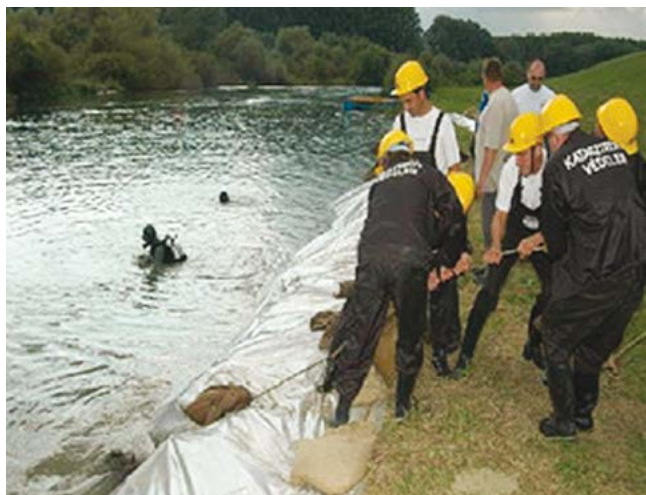
103. ábra Víz alatti fóliázás
