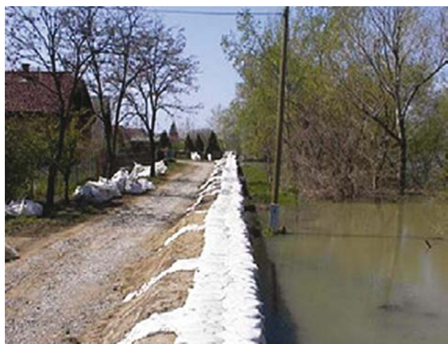
95. ábra Nyúlgát homokzsákból földmegtámasztással
