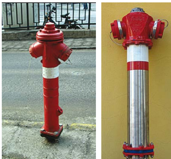
23. ábra Hagyományos öntöttvas, és új korrózióálló-acél anyagú föld feletti tűzcsapok szabályos megjelöléssel
