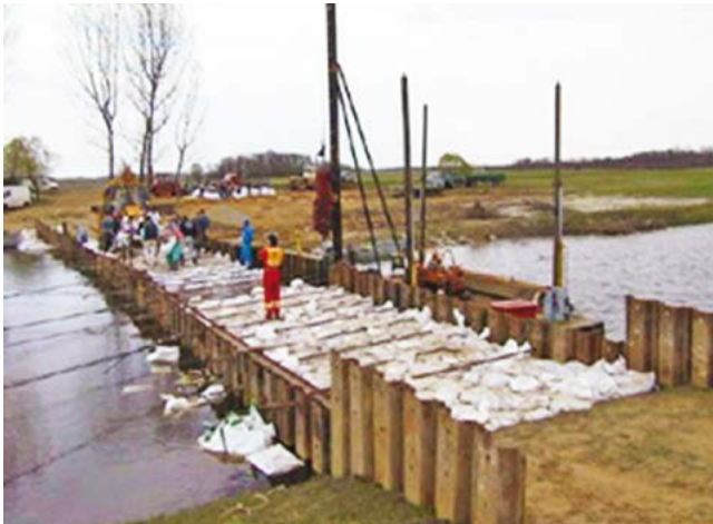
98. ábra Védekezés rézsúcsúszás ellen bordás megtámasztással
