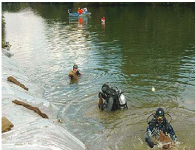
103. ábra Víz alatti fóliázás
