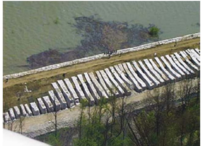
99. ábra Csurgás elzárása fóliaterítéssel és homokzsákokkal
